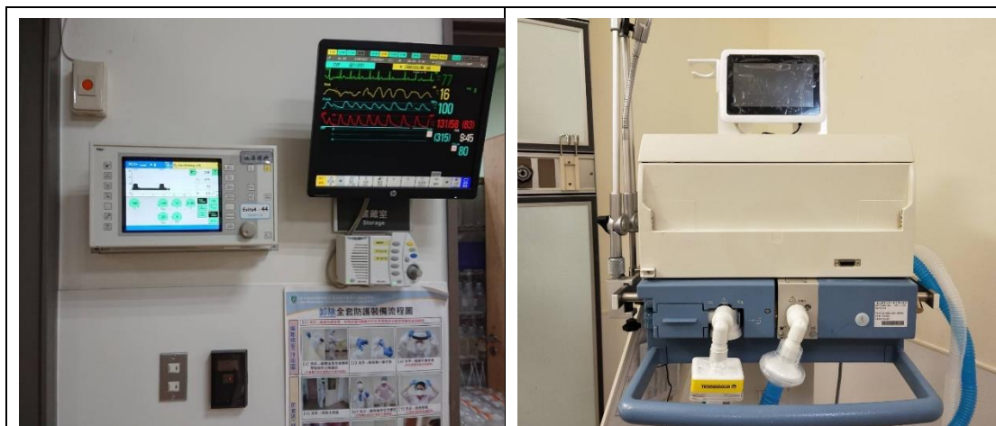
圖片來源：衛生福利部雙和醫院呼吸治療室。註：配置操控面板與主機分離式呼吸器時，應注意操作者是否可透過視訊或透明玻璃看到病人及生理監控儀。
